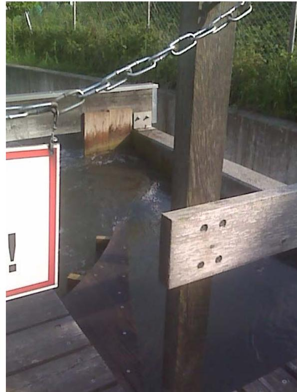
El vértice creado fuerza el giro de una turbina especialmente diseñada para la aplicación, al girar a la misma velocidad el agua y la turbina los objetos que pasen las barras de la bocana, ramas, botellas, etc no dañan ni afectan a la turbina ....
