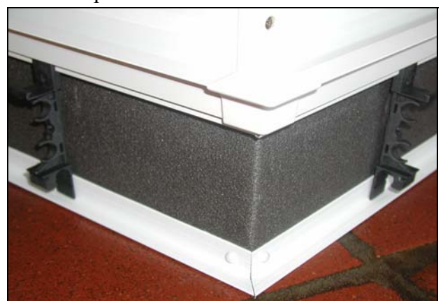
Abb. 8 AS: Skjøtestykket i ytterhjørnet blir tredd på topplista. Brakettavstand fra ytterhjørne er 15 cm til høyre og venstre.
