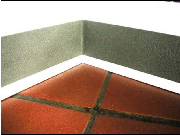
Abb. 5 Gulvlisten gjærdes i inner og ytterhjørne. Bruk en høyhastighet gjærdesag, fintannet.
