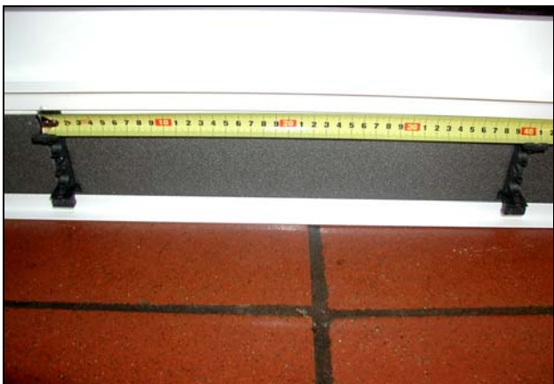
Abb. 7 TR: Det må være en avstand på 40 cm mellom festebrakettene. Aldri over 40 cm.
