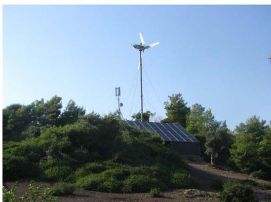
Instalación fotovoltaica: 3 x Sunny Mini Central 6000A; 17,88 kWp de potencia máxima
