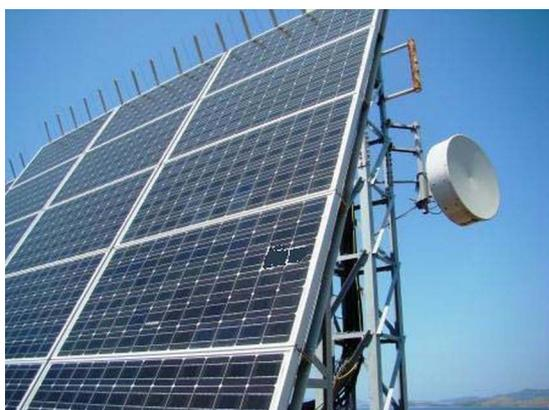
Instalación fotovoltaica: Sunny Boy 3300 y reguladores de carga; 11,5 kWp de potencia máxima
