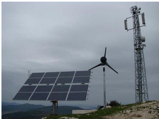
Instalación fotovoltaica: Seguidor solar con Sunny Boy 3000; 3,2 kWp de potencia máxima
