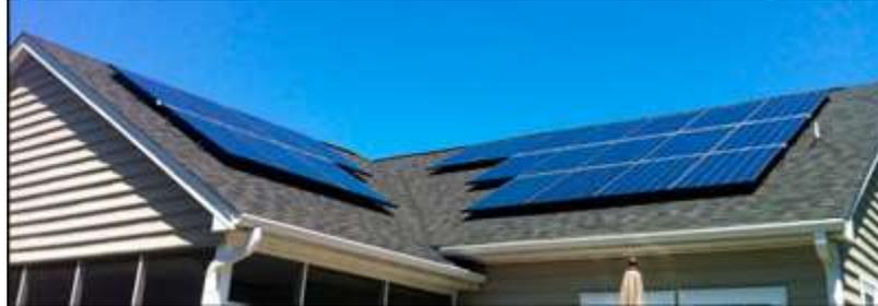
Los nuevos [inversores de autoconsumo](#) poseen en su mayoría 2 seguidores del punto de máxima potencia (MPPT) pensados precisamente para este propósito. De esta forma las placas solares con orientación Este se conectan a un MPPT y las placas orientadas al Oeste se conectan al otro MPPT.
