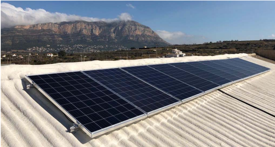
Autoconsumo 3kWp cerca del Parc Natural del Montgó, Denia. Instalador: Ponsfred S.L.
