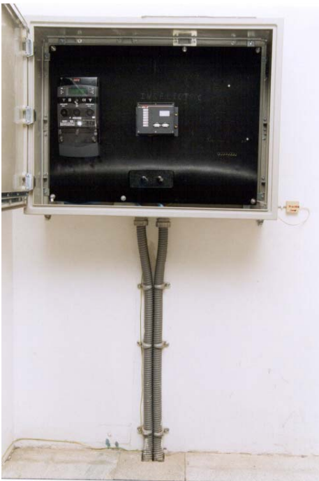
Módulo de Medida de dimensiones mínimas 750x750x300 mm de acuerdo a RPM según normas de Iberdrola.
