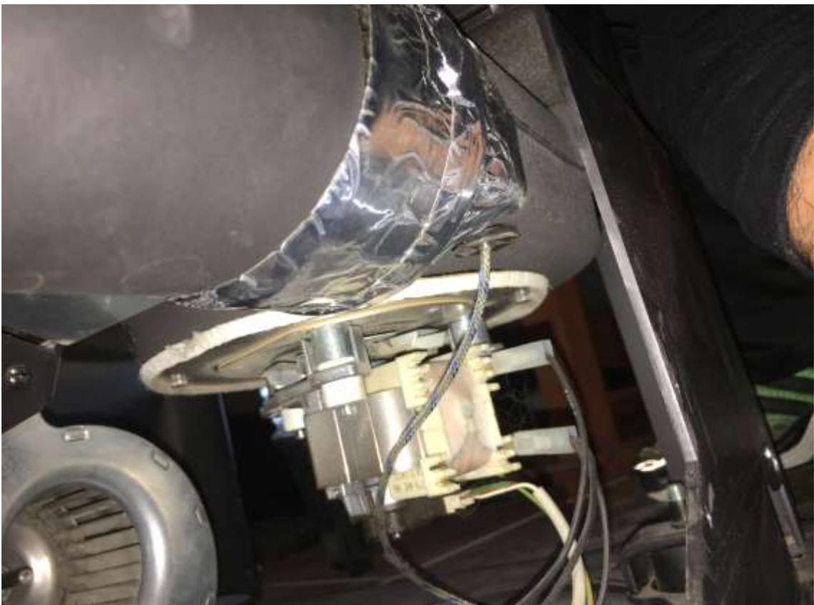
Detalle de la parte del motor por detrás, donde va unido al tubo de salida de humos, fijos que llega un cable que se mete dentro, imagino que es para medir la temperatura de los humos, con el tiempo seguro que hay que limpiar.
